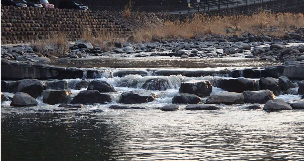
凹型巨石群魚道
